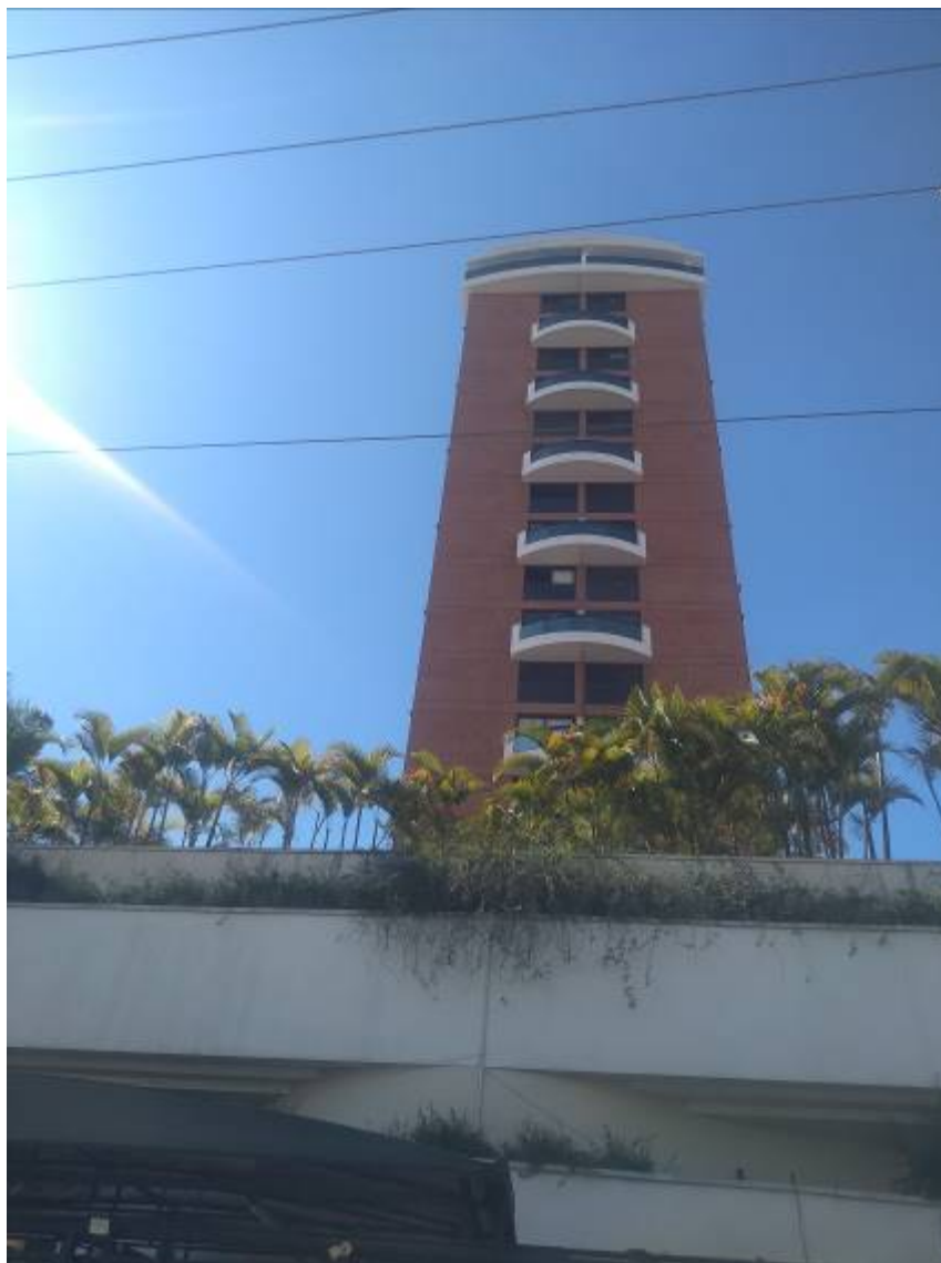
FOTO 4: FACHADA DO EDIFÍCIO.
