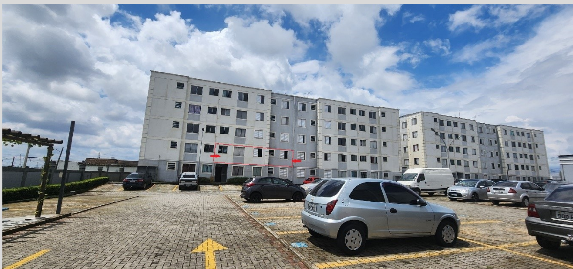
Vista do Bloco 04, apartamento avaliando localizado no segundo pavimento.
