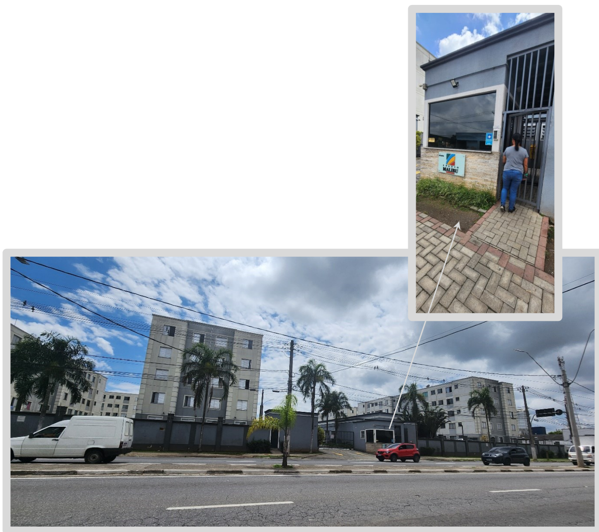
Avenida Lourenço de Souza Franco, nº 871, Residencial Spazio Malibu em Jundiapéba, Mogi das Cruzes. Portaria 24h.
