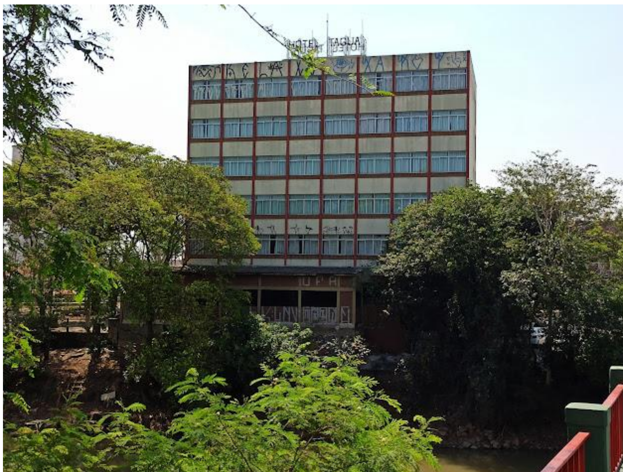
Fotos 2 a 5: Vistas externas do imóvel avaliando.
