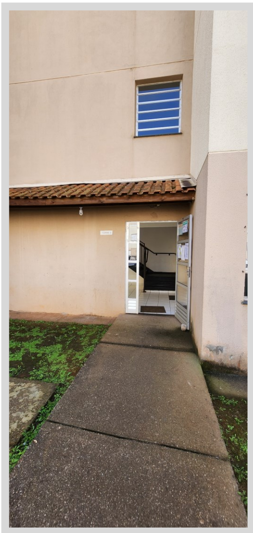
Acesso a Torre 3.
