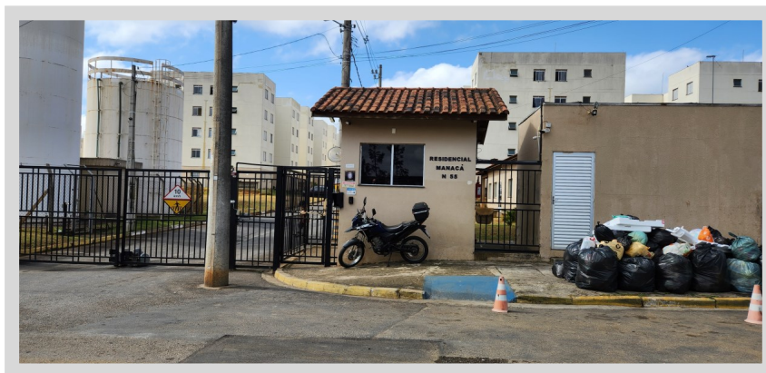
Portaria de acesso ao Condomínio Residencial Manacá.
