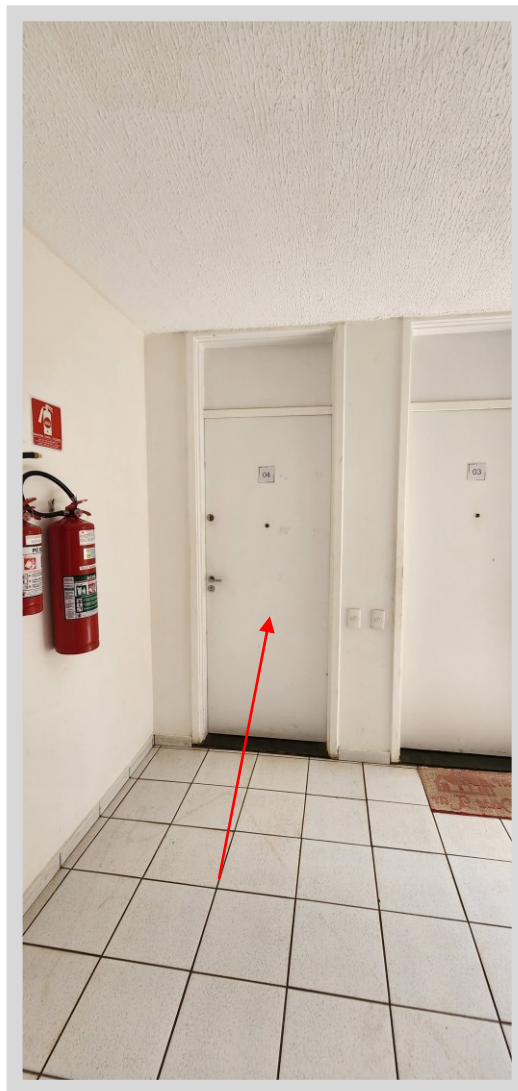
Apartamento avaliando: 04 no térreo da Torre 03.
