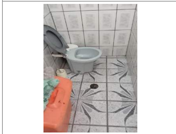
22 - DETALHE DO ACABAMENTO DO W.C. ÁREA COBERTA FUNDOS - TÉRREO
