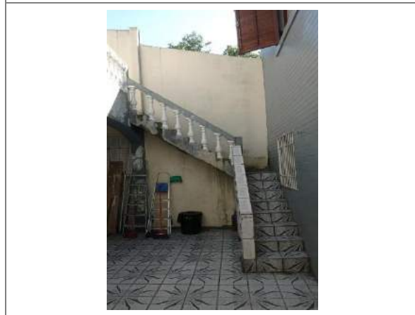
24 - GERAL DA ESCADA DE ACESSO AO TERRAÇO DA ÁREA COBERTA FUNDOS - TÉRREO
