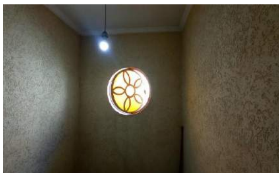
45 - DETALHE DO ACABAMENTO DO VÃO DA ESCADA
