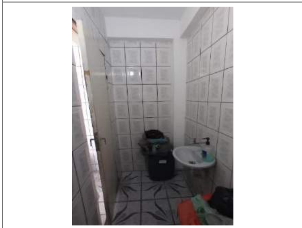
21 - OUTRA GERAL INTERNA W.C. ÁREA COBERTA FUNDOS - TÉRREO
