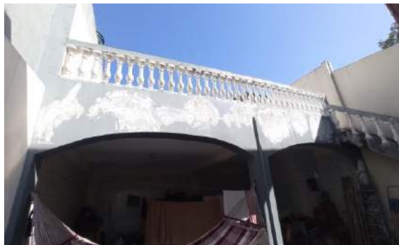
25 - DETALHE DO TERRAÇO
