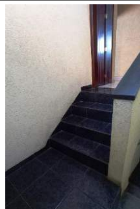
42 - OUTRO DETALHE DA ESCADA DE ACESSO AO PAV. SUPERIOR
