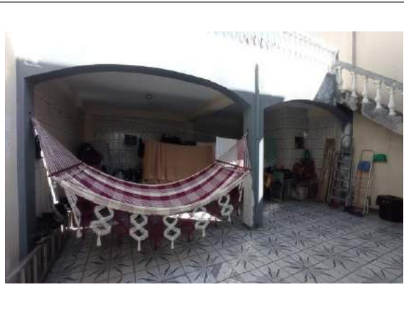
13 - VISTA GERAL DA ÁREA COBERTA NOS FUNDOS - PAV. TÉRREO
