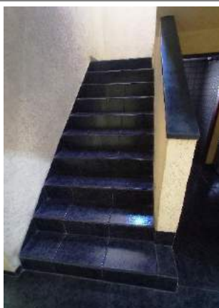
41 - DETALHE DA ESCADA DE ACESSO AO PAV. SUPERIOR
