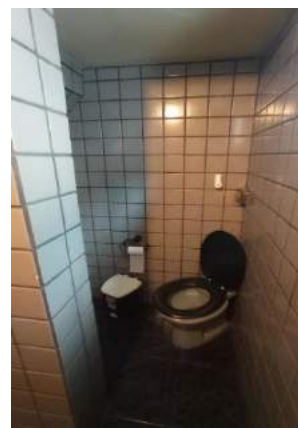
40 - OUTRA VISTA INTERNA DO LAVABO - PAV. TÉRREO
