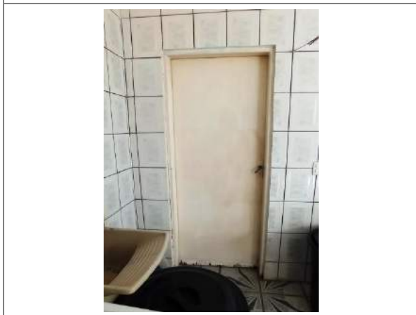
19 - PORTA DE ACESSO AO W.C. DA ÁREA COBERTA FUNDOS - TÉRREO
