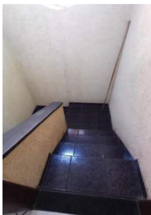
43 - OUTRO DETALHE DA ESCADA DE ACESSO AO PAV. SUPERIOR
