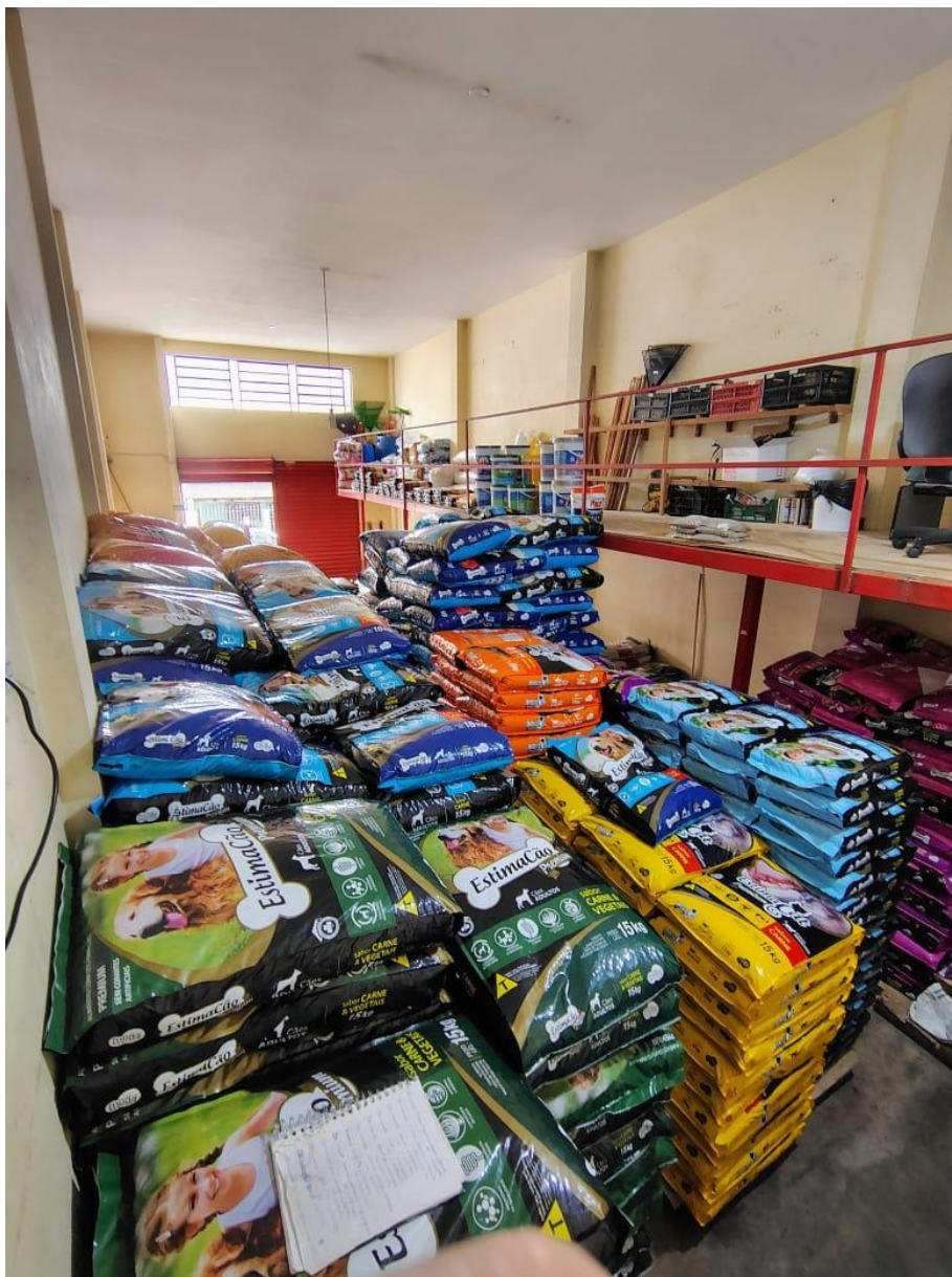
Imagem interna do Depósito, onde pode-se observar superestrutura em concreto armado com mezanino metálico.
