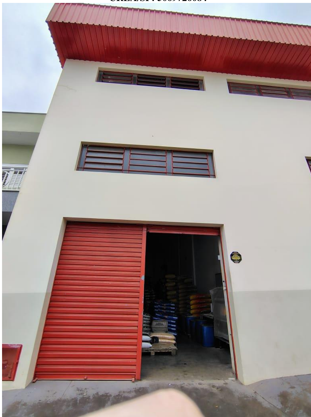
Imagem do acesso na Rua José Piloto parte do Depósito.
