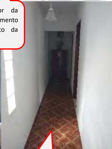
Vista do interior da edificação 2º Pavimento do imóvel objeto da perícia.
