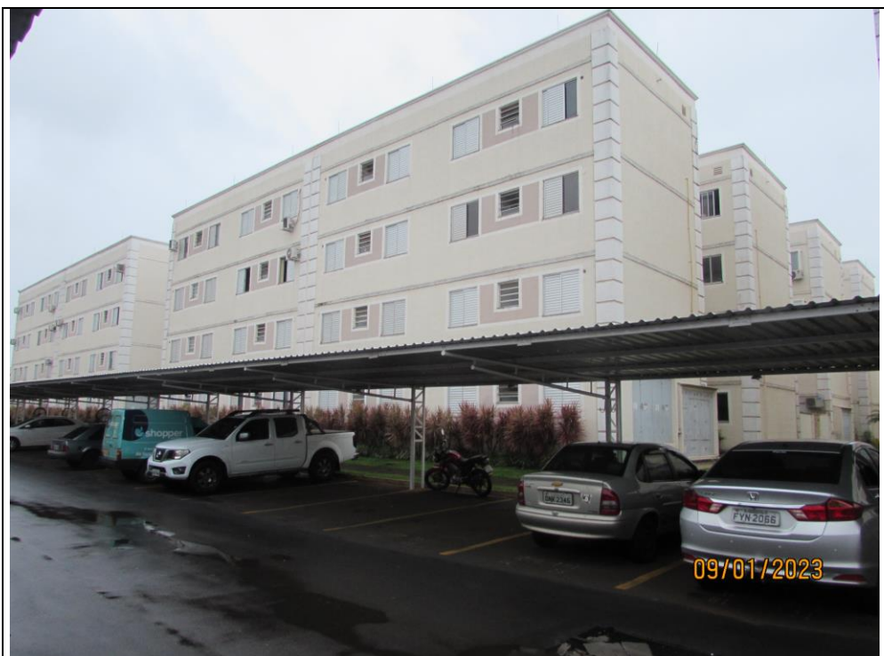
FOTO 01: Fachada do bloco onde fica o apartamento da Ré.
