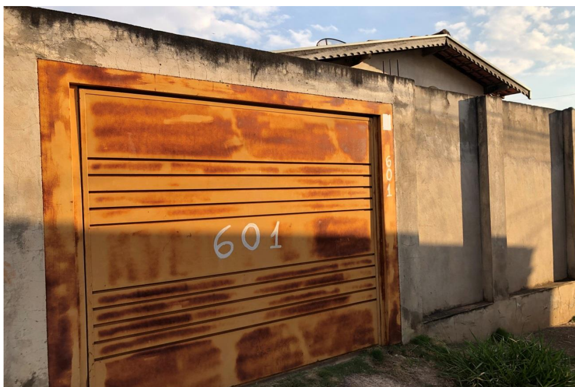
Foto nº 04: Vista da fachada do imóvel vendo-se a numeração.
