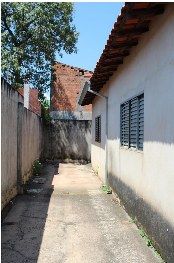
Foto nº 06: Vista do recuo lateral do imóvel vendo-se haver uma edificação térrea erigida em alvenaria e coberta com telhas de barro e esquadrias de alumínio.
