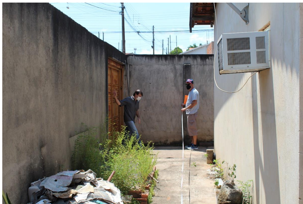
Foto nº 05: Vista do recuo frontal da edificação.
