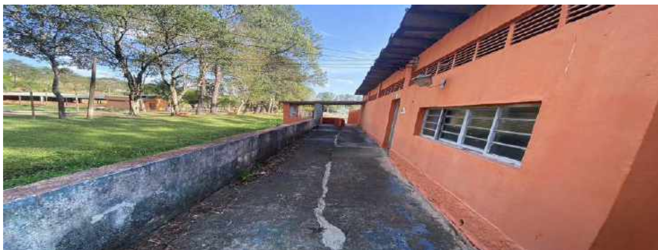
VISTA VESTIÁRIOS PISCINA
