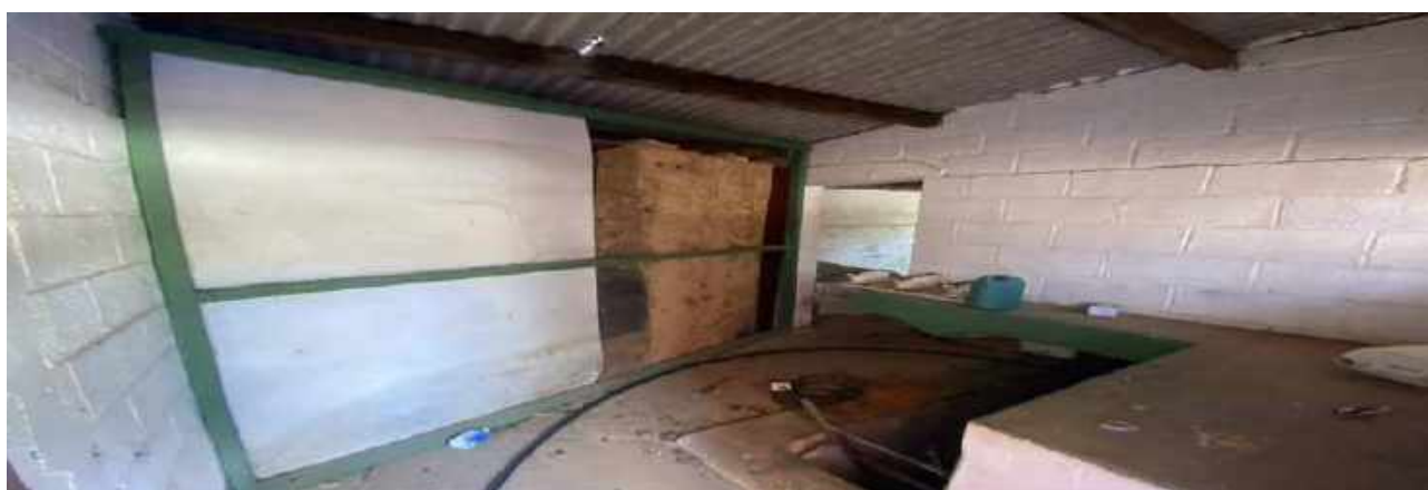
VISTAS CASA DE BOMBAS E POÇO ARTESIANO
