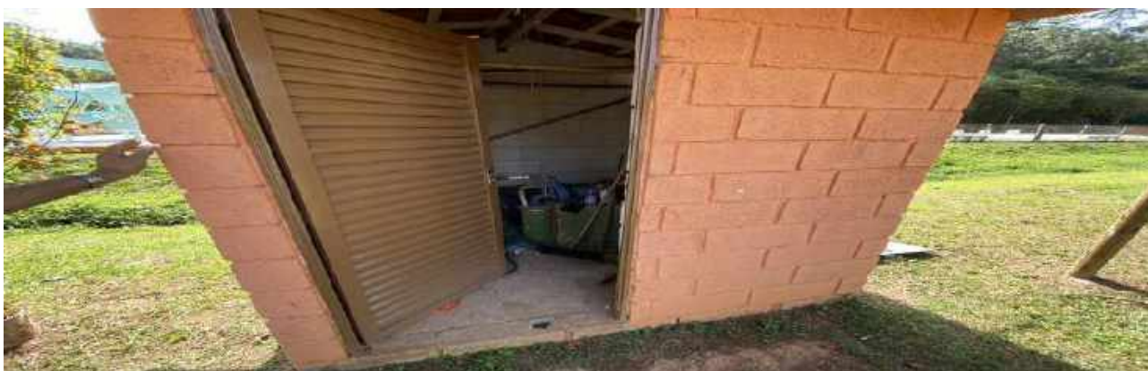
VISTA POÇO ARTESIANO
