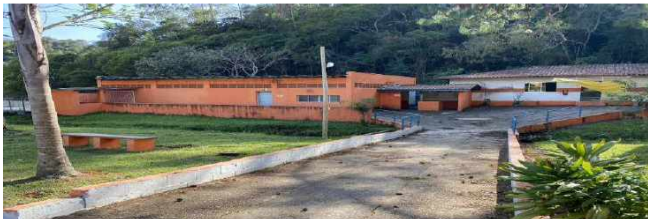
VISTA RESTAURANTE DA PISCINA/VESTIÁRIOS E BANHEIROS
