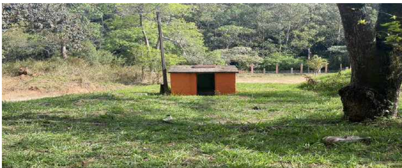
VISTA ABRIGO POÇO DESATIVADO
