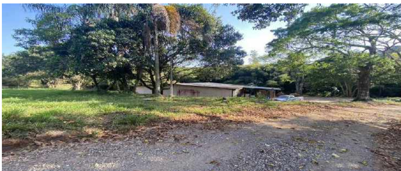
VISTA GALPÃO DE MARCENARIA
