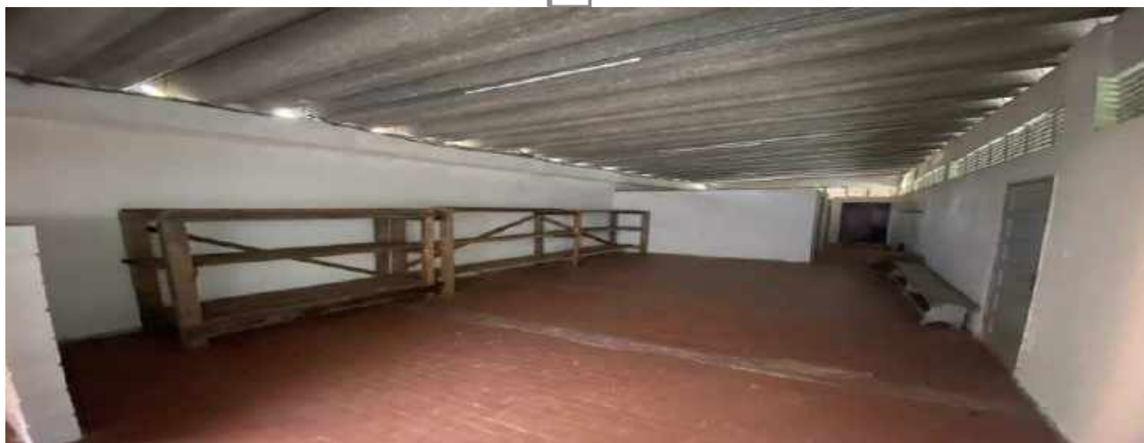
VISTA VESTIÁRIOS DO ANTIGO RESTAURANTE
