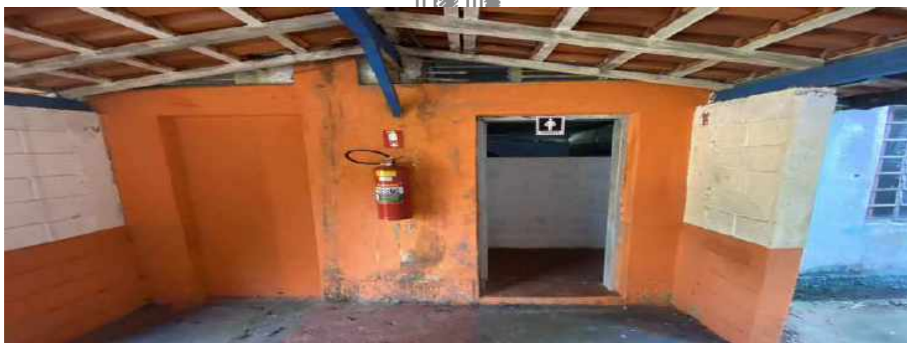
VISTA BANHEIROS ANTIGO RESTAURANTE
