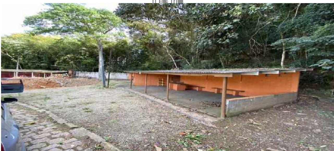
VISTA BARRACA DO LAGO E DEPÓSITO AOS FUNDOS
