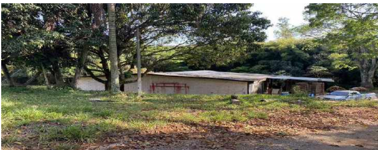
VISTA GALPÃO DE MARCENARIA
