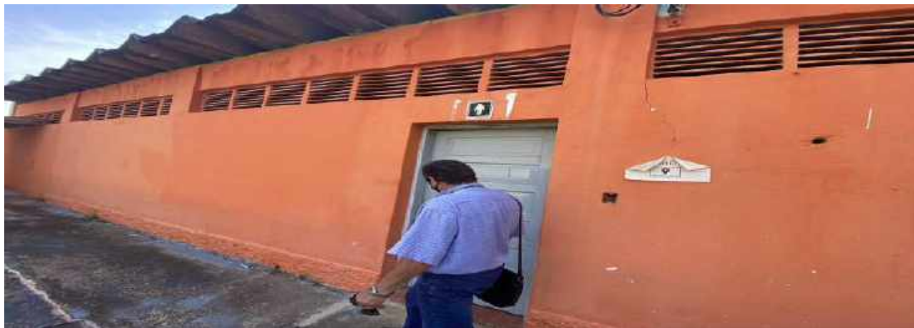
VISTA BANHEIROS DO ANTIGO RESTAURANTE
