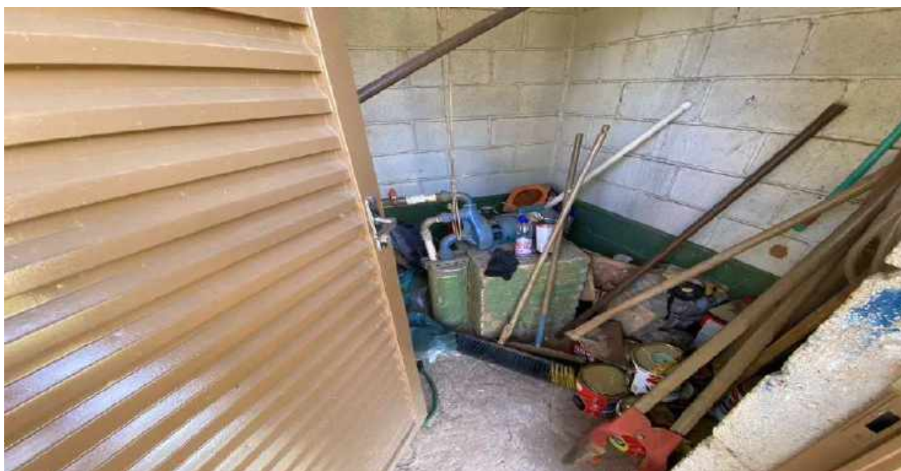
VISTA POÇO ARTESIANO
