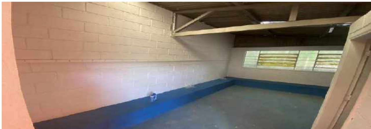
VISTA VESTIÁRIOS PRÓXIMA QUADRA
