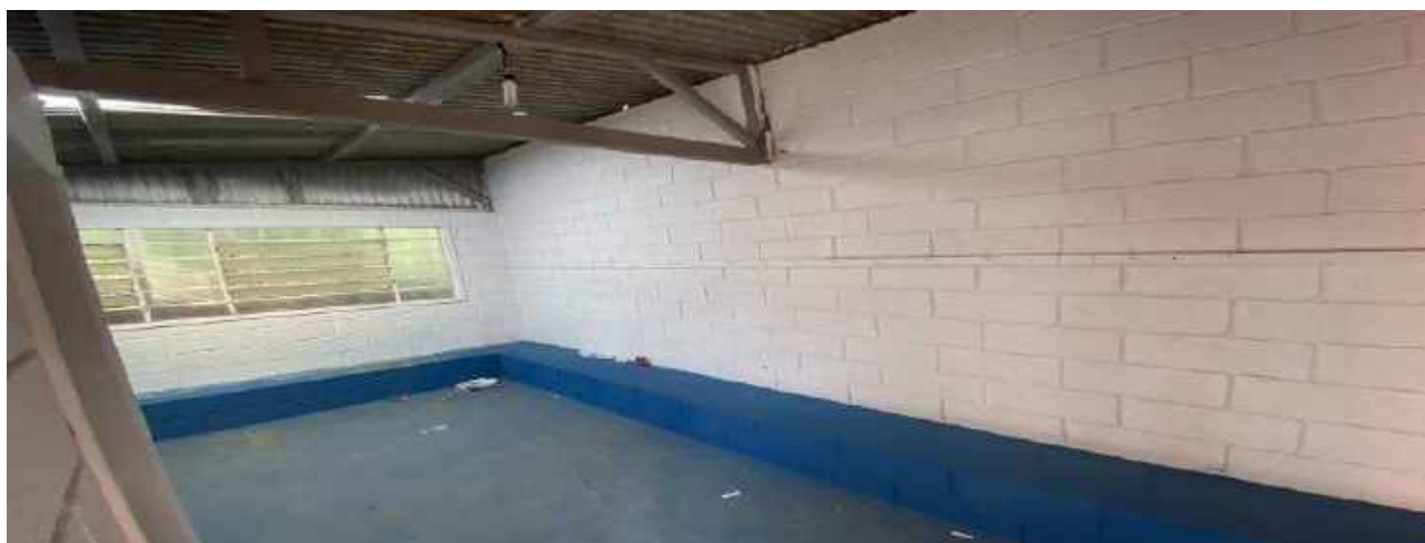
VISTA VESTIÁRIOS PRÓXIMA QUADRA
