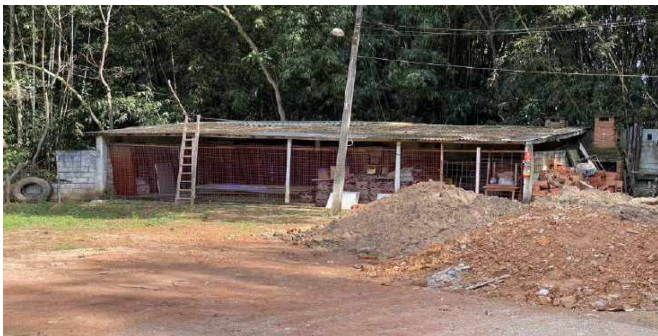
VISTA DEPÓSITO PRÓXIMO BARRACAS DO LAGOS
