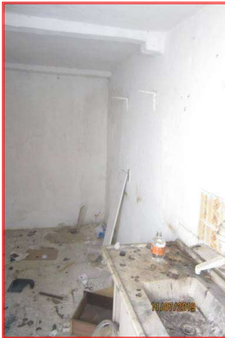
Foto nº 17: Vista parcial da cozinha (residência 04).
