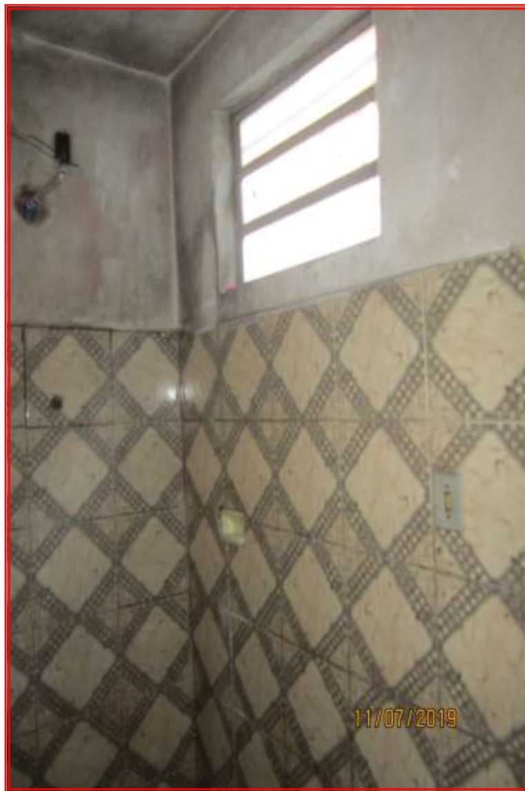
Foto nº 15: Vista parcial do banheiro (residência 03).
