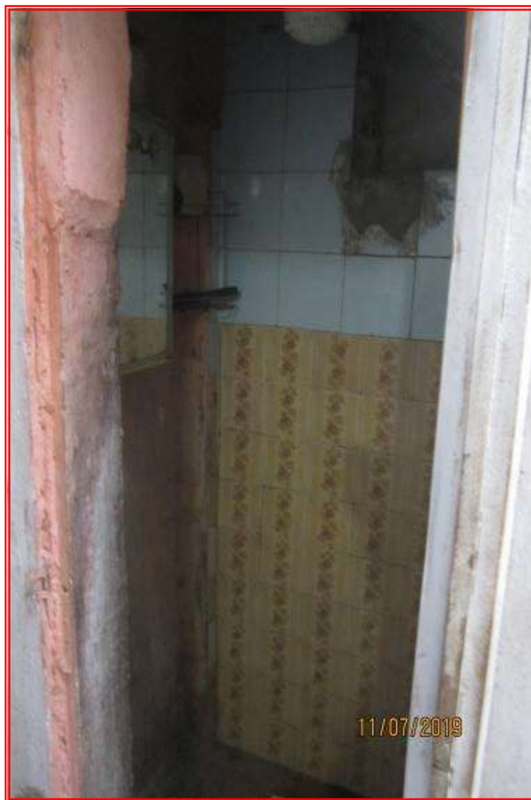
Foto nº 09: Vista parcial do banheiro (residência 02).
