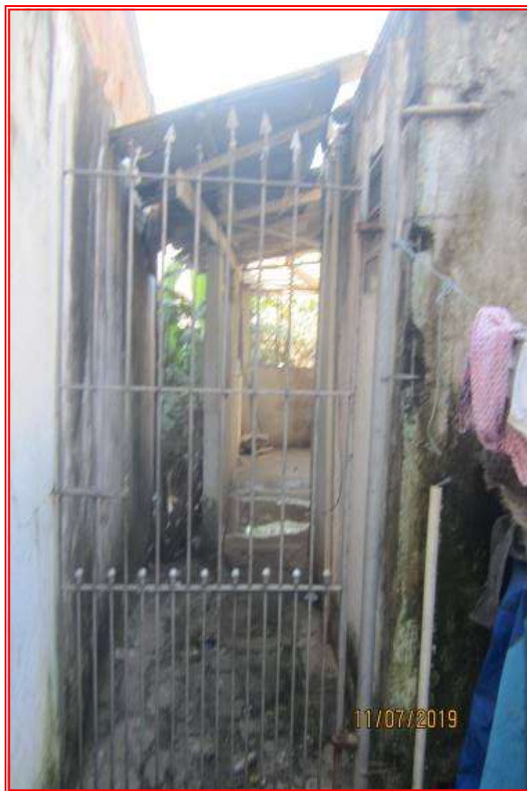
Foto nº 11: Acesso a residência 03 e 04.
