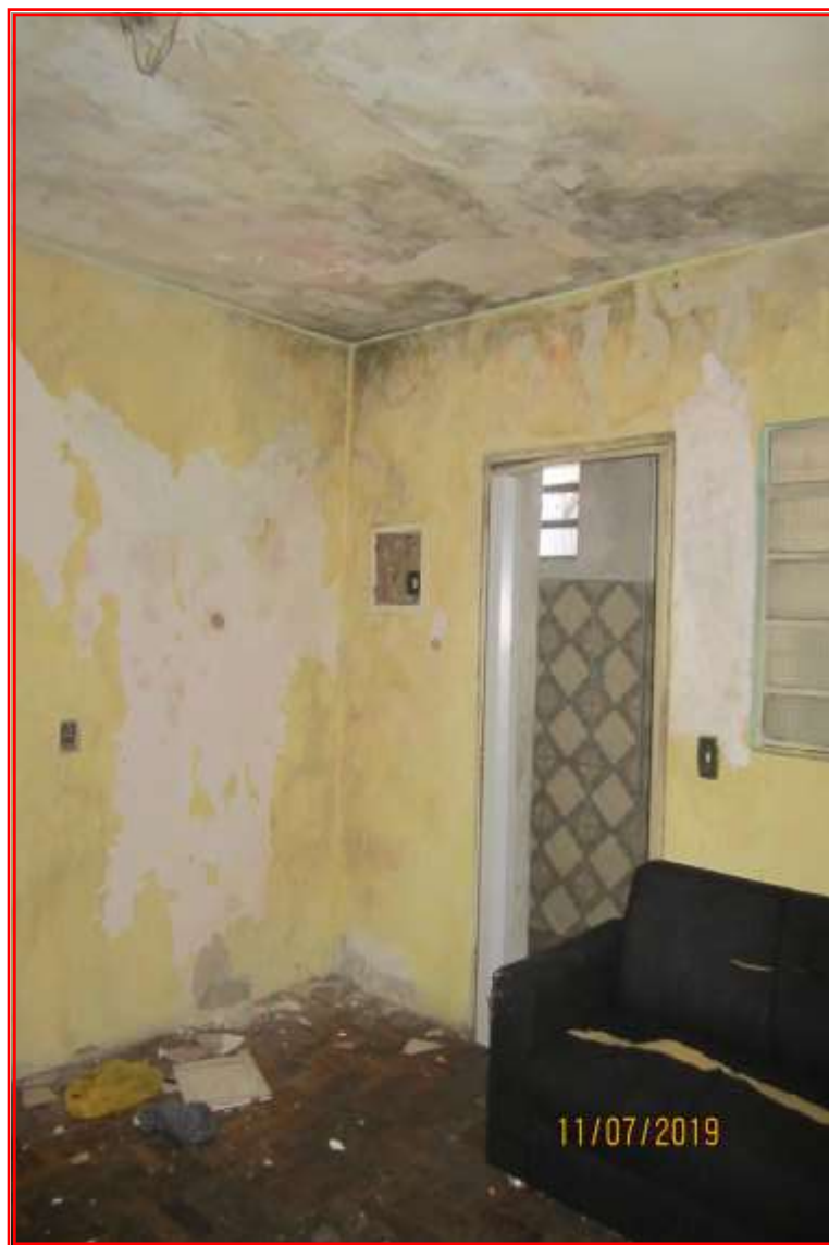
Foto nº 14: Vista parcial da sala (residência 03).
