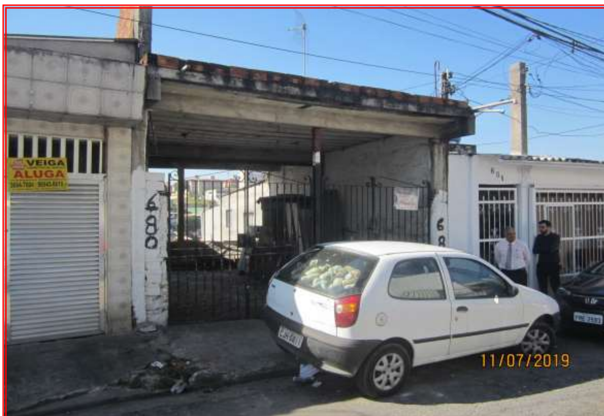
Foto nº 01: Vista geral da fachada do imóvel.
