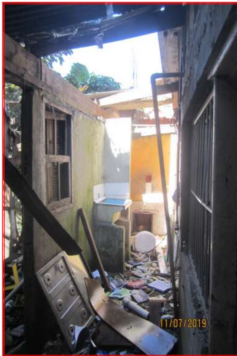
Foto nº 16: Vista parcial da antiga área de serviço (residência 04).
