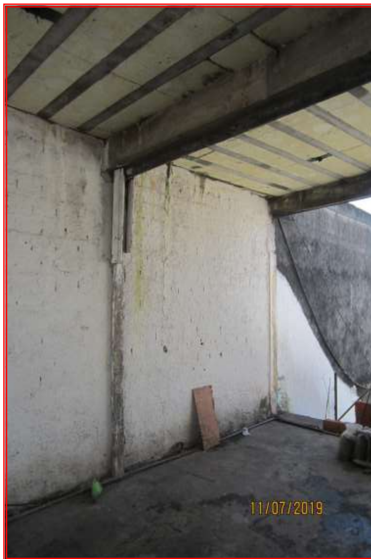
Foto nº 02: Vista da garagem coberta.
