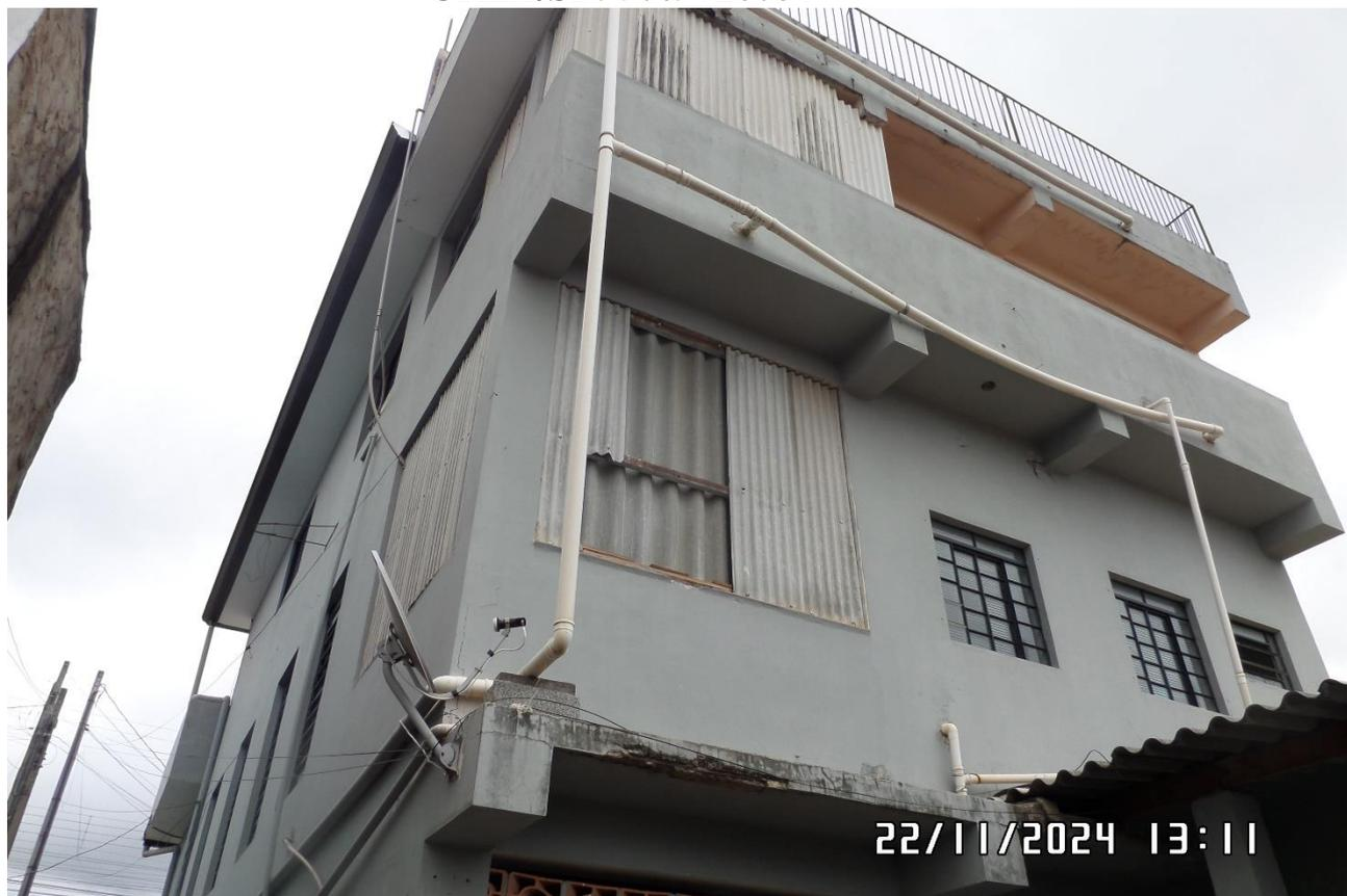
Imagem 10 - da edificação principal vista pelos fundos onde pode-se observar que faltam duas janelas, tubulações externas, padrão simples.
