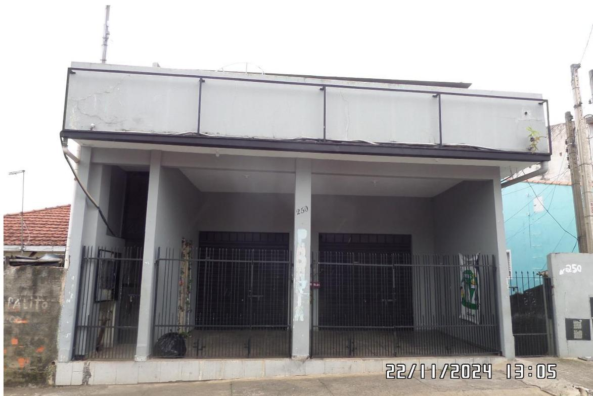
Imagem 2 - complementar à anterior, vista da fachada onde é possível observar o baixo estado de conservação da pintura, presença de fissuras, pontos de umidade.
