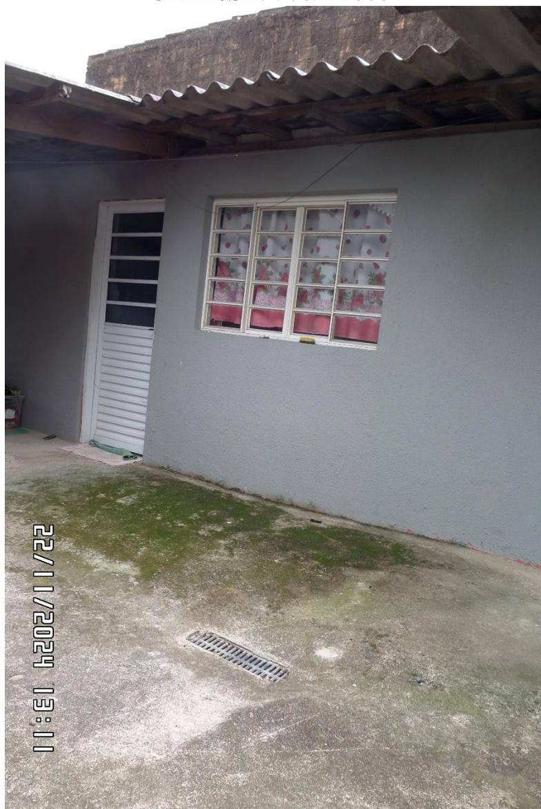
Imagem 8 - da edificação ao fundo padrão simples, sinais de umidade, telhado de fibrocimento.
