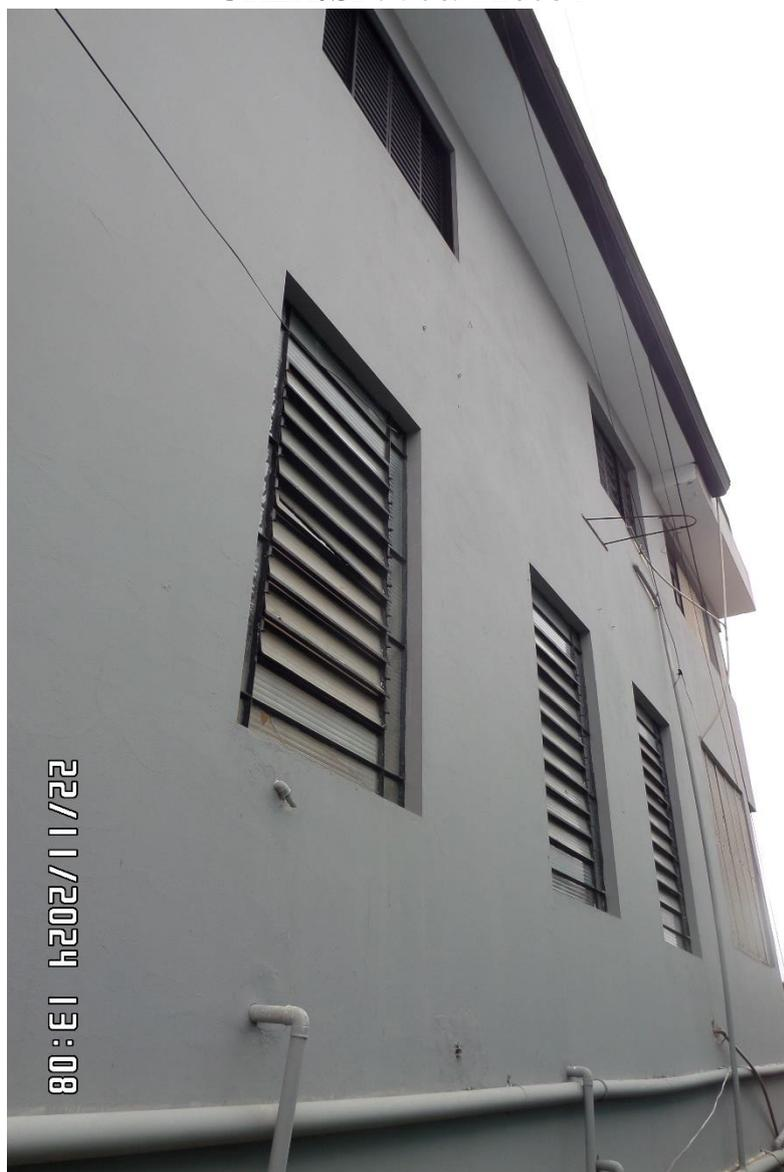
Imagem 4 - Parte externa pelo corredor lateral onde pode-se observar as esquadrias em padrão inferior de ferro e vidro, tubulações externas.
