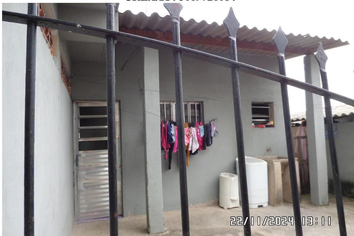
Imagem 9 - da segunda edificação ao fundo padrão simples, sinais de umidade, telhado de fibrocimento.
