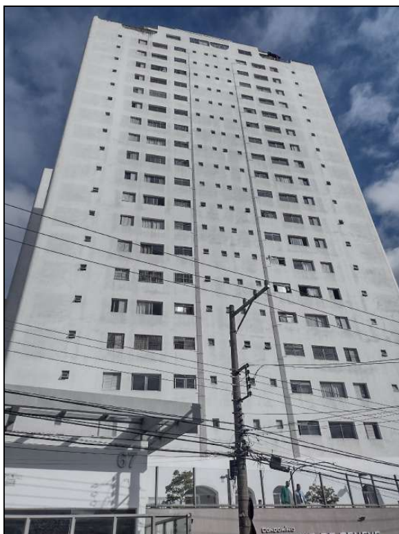
Vista da fachada do bloco "A" – "Edifício Biarritz".
