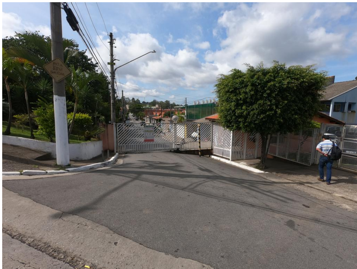
Figura 3. Fachada do condomínio.
