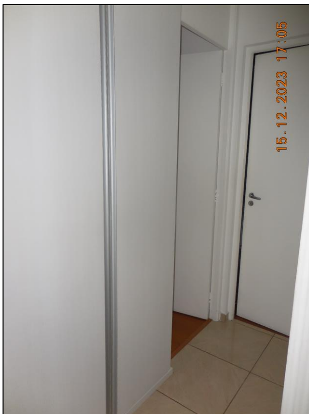
FOTOGRAFIA Nº 21: Vista do hall de acesso aos dormitórios.
