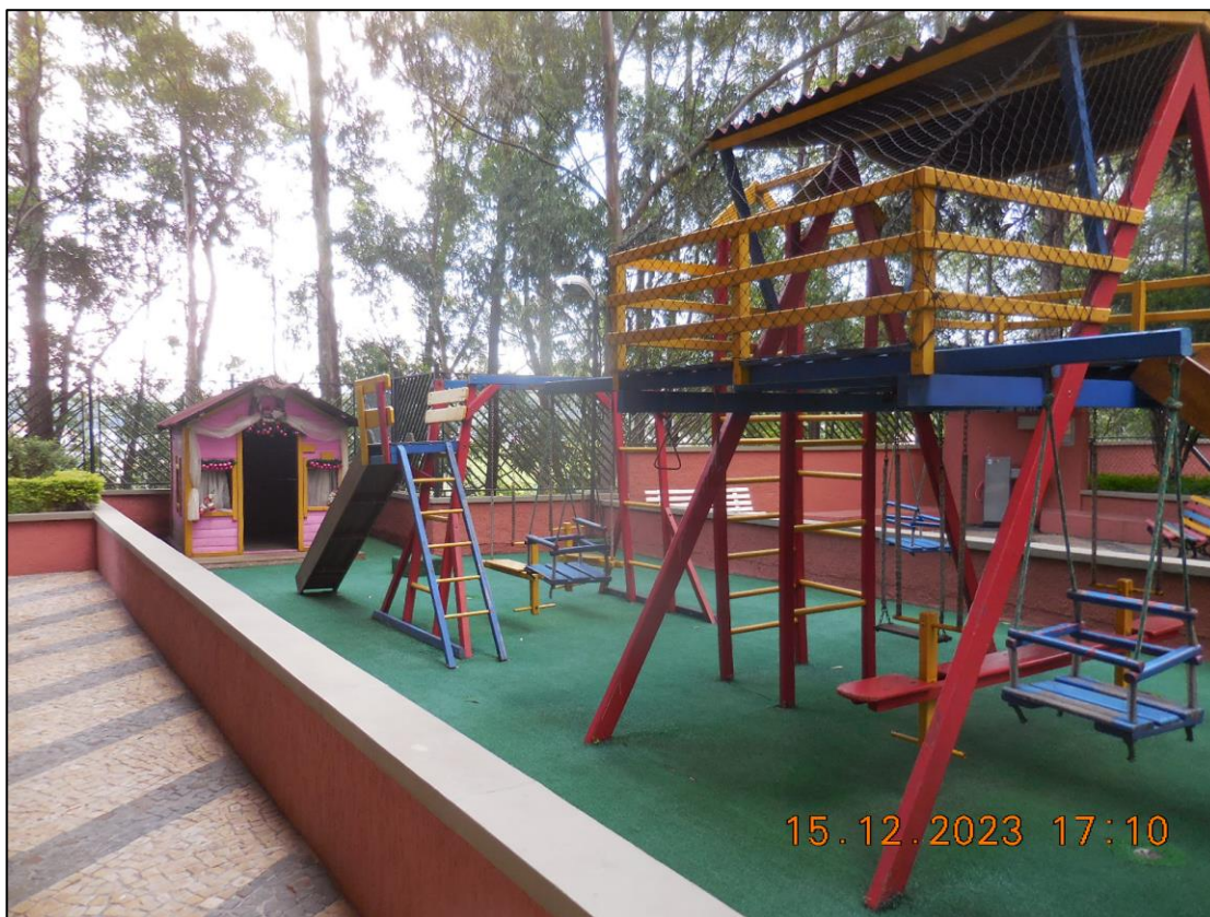
FOTOGRAFIA Nº 14: Vista do playground.
