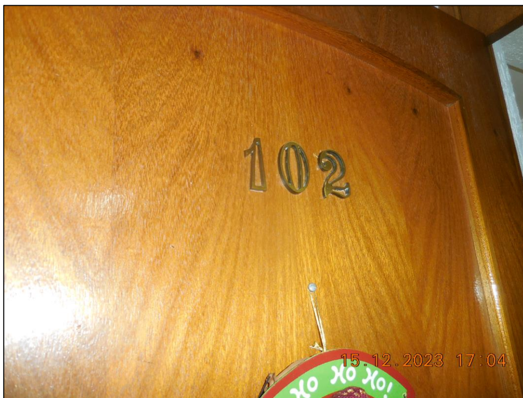
FOTOGRAFIA N° 16: Vista da identificação da unidade n° 102 – bloco 3.
