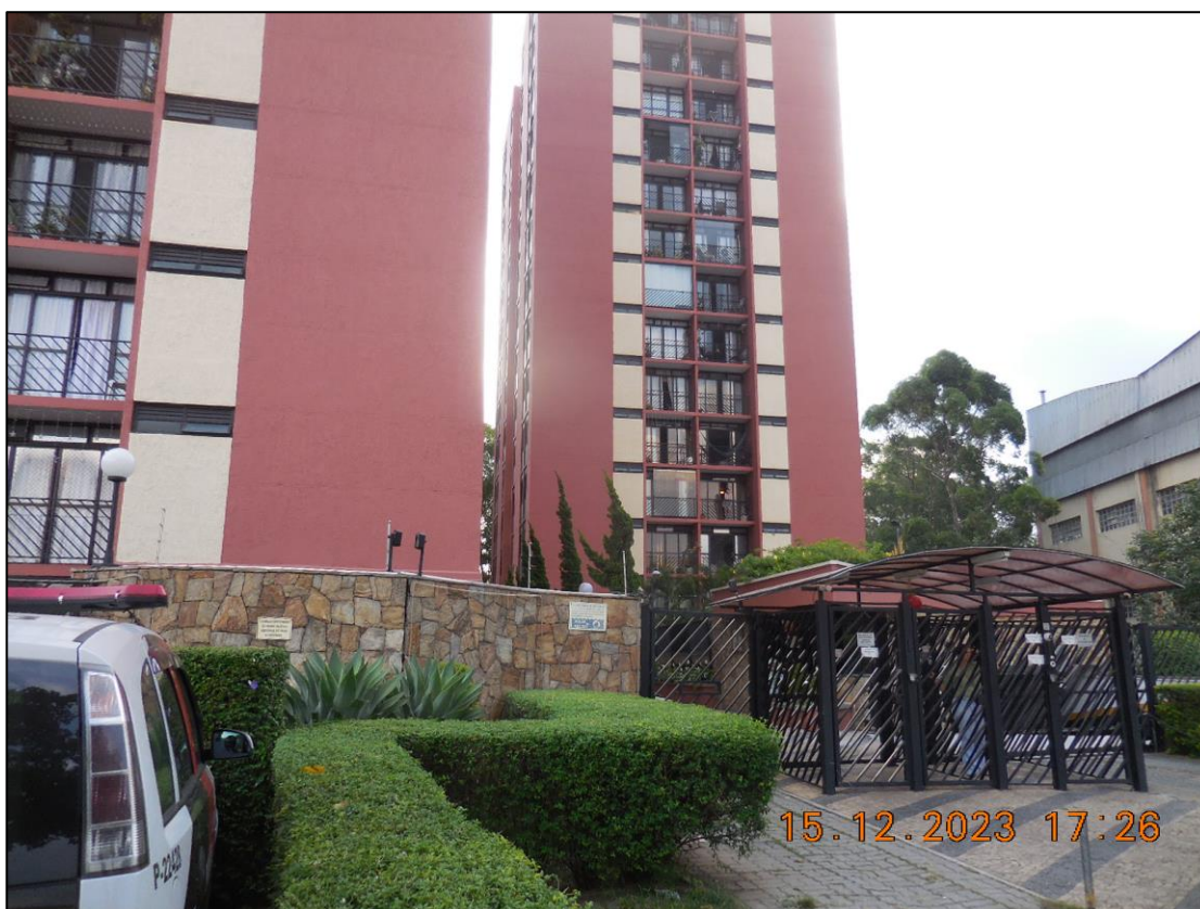
FOTOGRAFIA N° 03: Vista do controle de acesso do Condomínio American Life.
