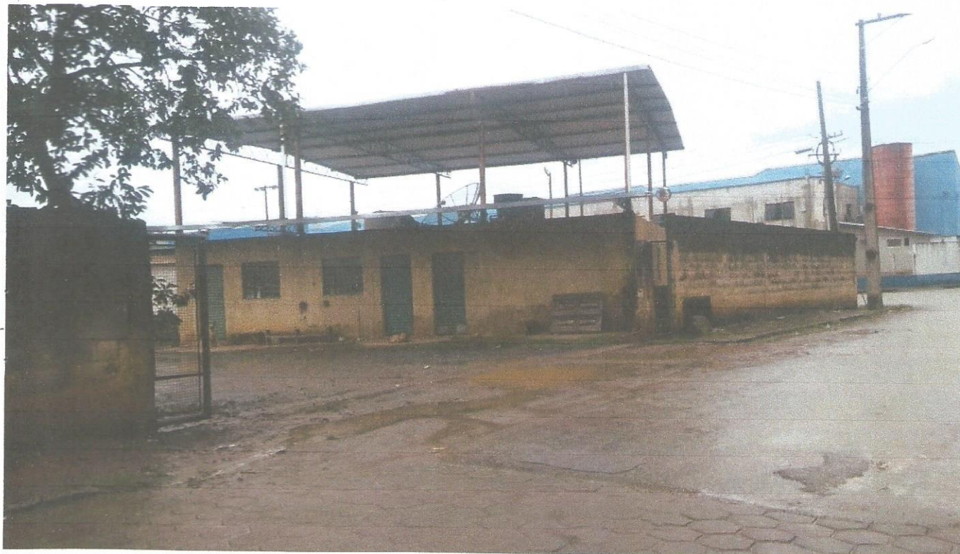
Estrada da Ribeirada (02) Edificação simples
